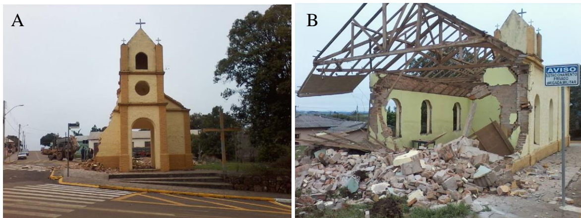
Figura 5: a e b) Desconstrução da Igreja Matriz de Nossa Senhora dos Remédios (Quevedos, RS).
