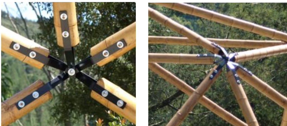
Figura 4. Detalhe dos conectores metálico na Cúpula Geodésica. Fonte: Os autores.
