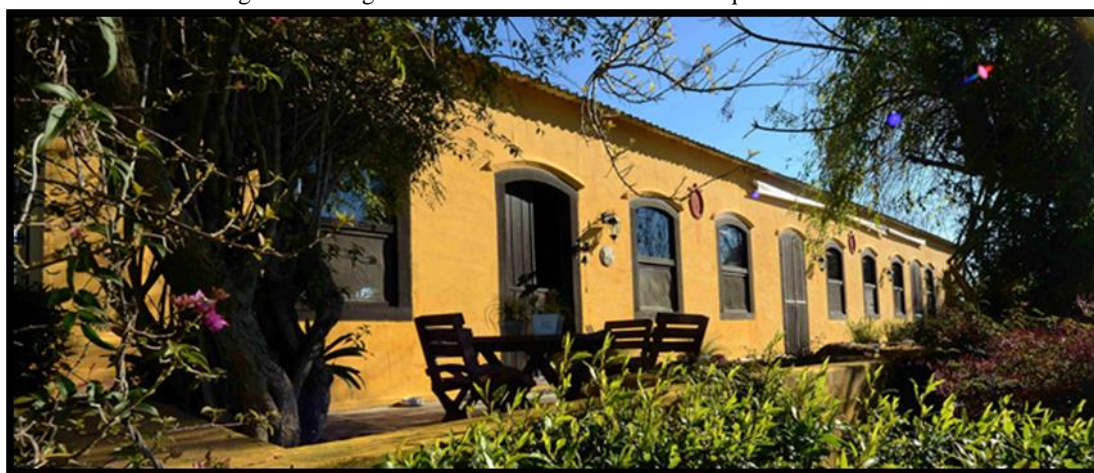
Figura 2: Fotografia da fachada do imóvel da charqueada Boa Vista
