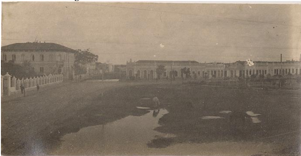
Figura 8 – Vista da Rua 24 de Maio – 1912.
