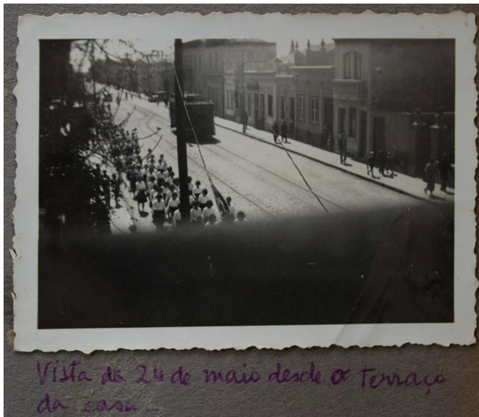
Figura 6 – Bonde elétrico na Rua 24 de Maio.
