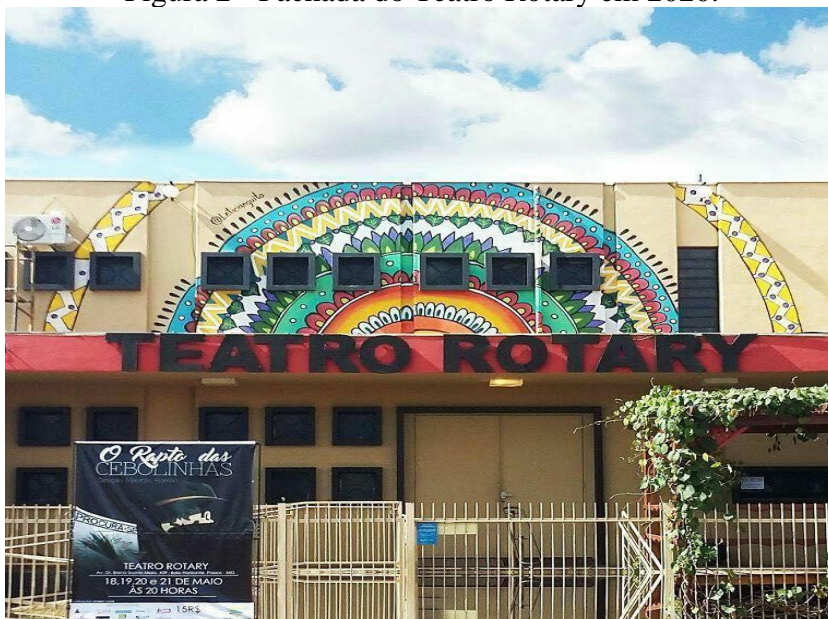
Figura 2 - Fachada do Teatro Rotary em 2020.
