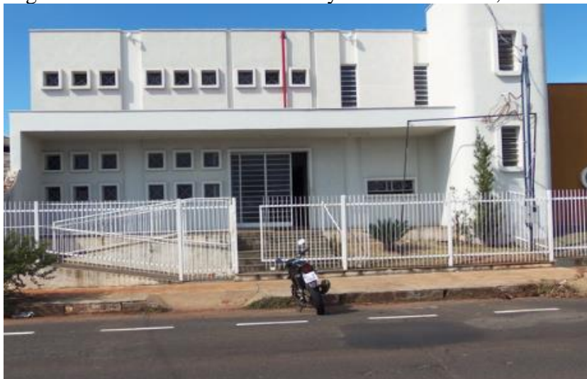
Figura 1 - Fachada do Teatro Rotary antes da reforma, em 2014.
