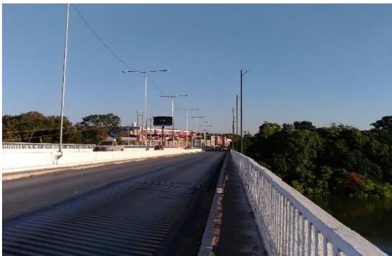
Figura 04 – Calçada da Ponte Júlio Müller Fonte: Autora, 2017.
