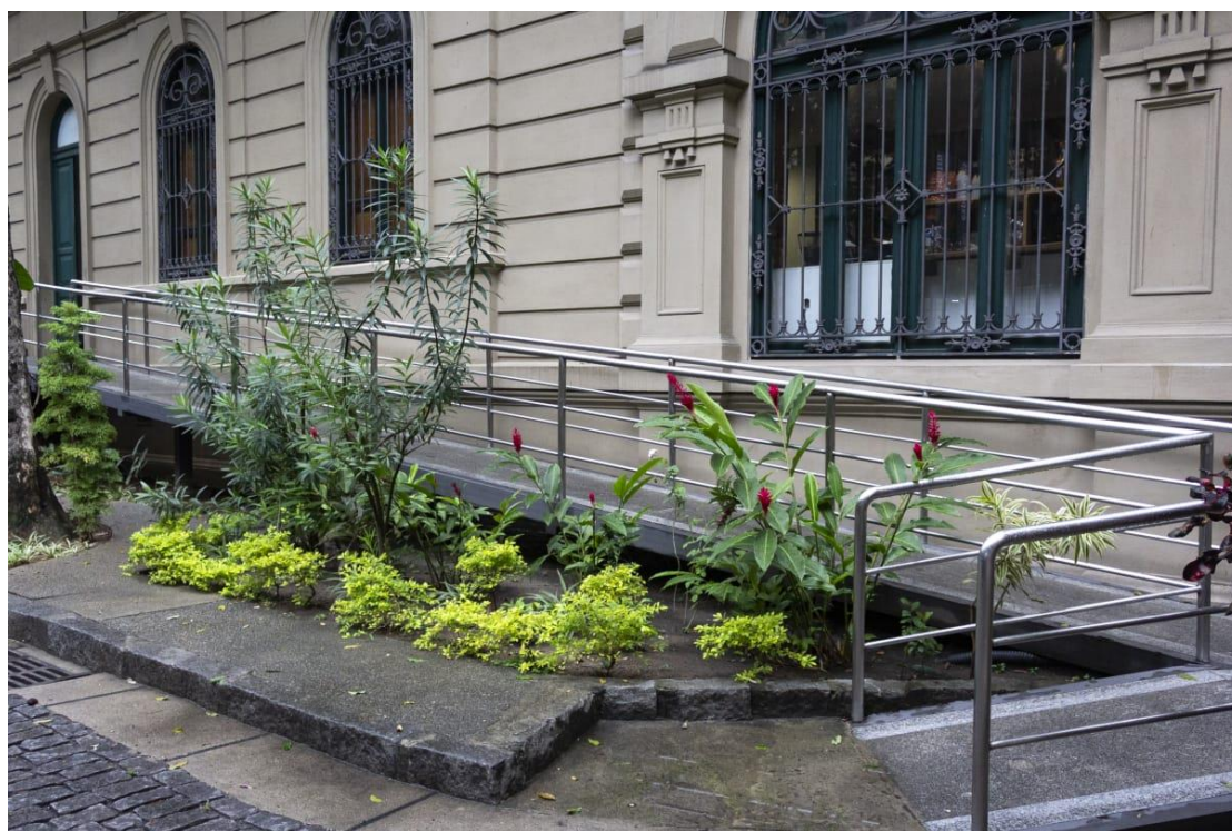
Fotografia 5: Rampa de acessibilidade localizada no estacionamento
