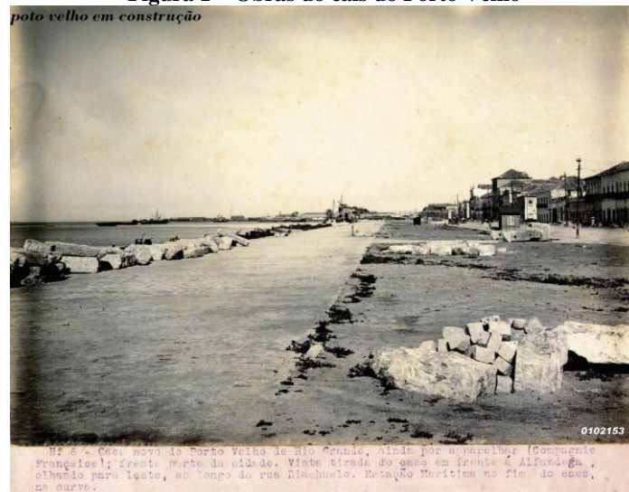
Figura 1 – Obras do cais do Porto Velho
