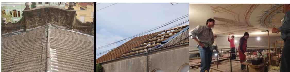
Figura 3 _ Foto 01: telhado antes do restauro. Foto 02: durante o restauro. Foto 03: Restauro do teto interno. Fotos do acervo da SECULT
