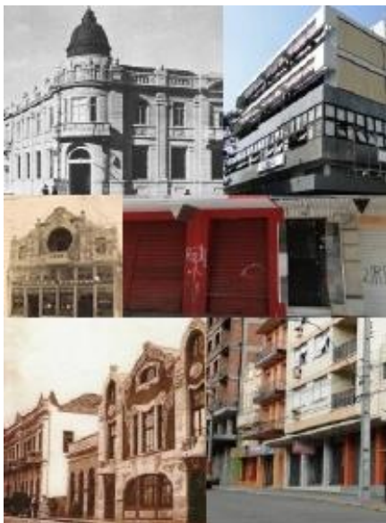
Fig. 12 – Montagem do antes e depois, alguns prédios que foram demolidos Fonte: Arquivo pessoal, Revista ATC, 2010.
