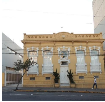
Fig.7 Residência Álvares Cunha Fonte: Arquivo Pessoal (2015)
