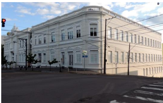
Fig. 5. Edifício Hugo Taylor Fonte: Arquivo Pessoal (2015)
