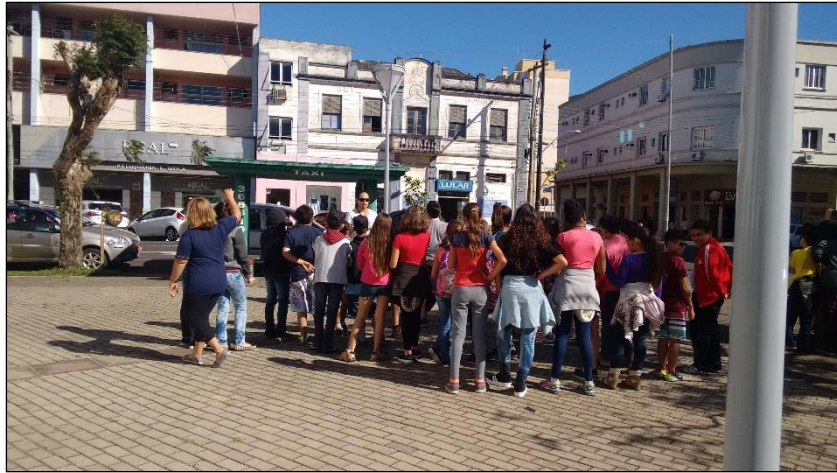
Figura 4: Prédio da Antiga Intendência
